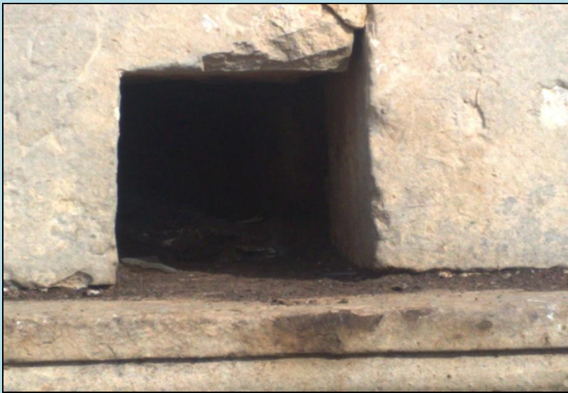
Buche pontate, prive di tamponatura, parassitate da piccioni. Vegetazione superiore.
