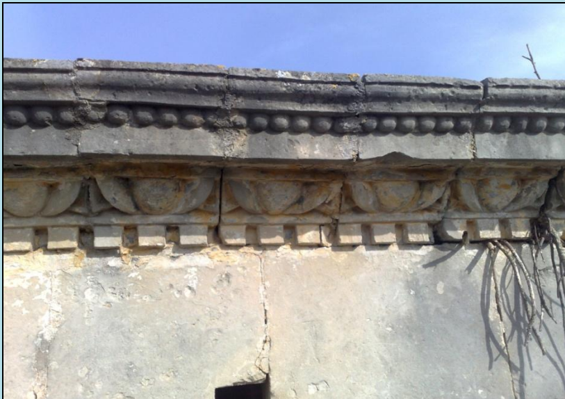
Buche pontate, prive di tamponatura, parassitate da piccioni. Vegetazione superiore.
